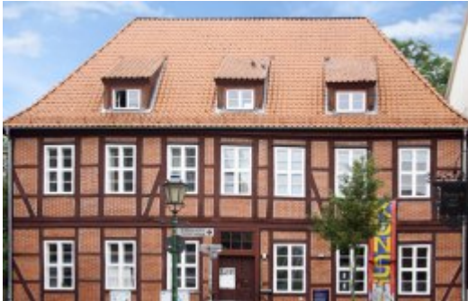
Das Kanzlerhaus in der Neuen Straße.
