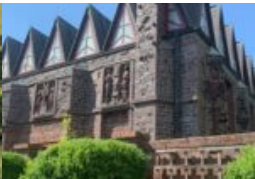
Verfugt, ersetzt und gefestigt
