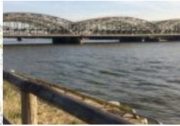
Die Freihafen- Elbbrücke
