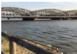
Die Freihafen- Elbbrücke
